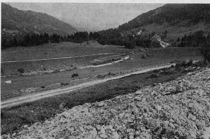
Una visione di Passo Croce d'Aune dove sono ancora in corso importanti lavori per la definitiva sistemazione della strada. Si tratta di una zona turistica di primaria importanza per il Feltrino che dovrebbe avere un notevolissimo sviluppo proprio con il miglioramento della viabilità.
