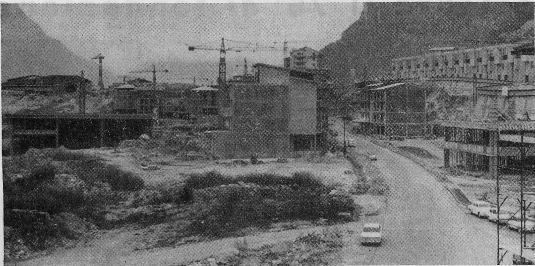
Il centro di Longarone, pieno di cantieri.
