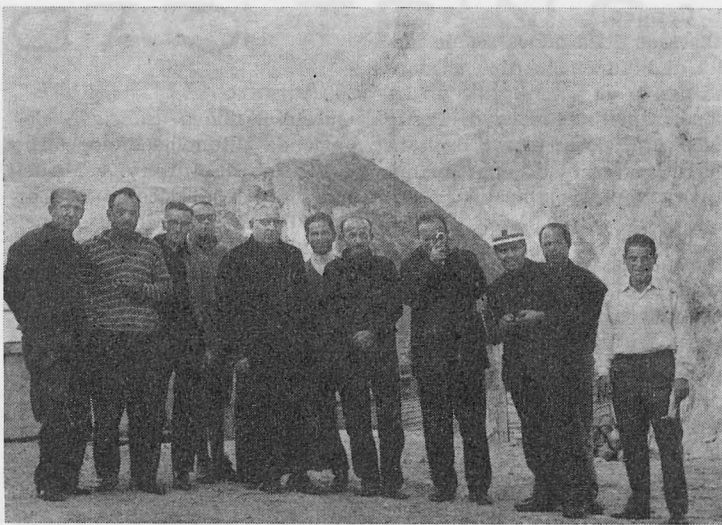
Sua Ecc. il Vescovo con alcuni operai del cantiere di Robiei.
