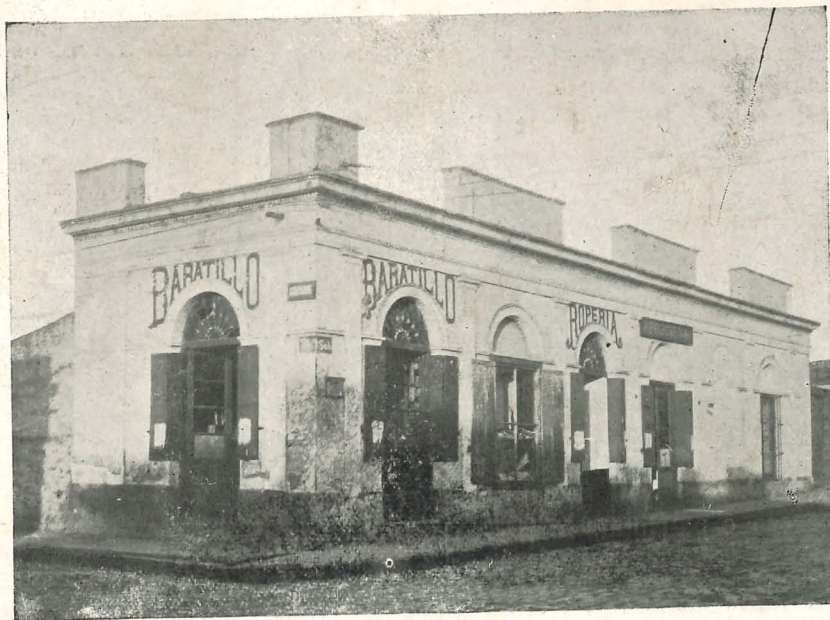
FACCIATA DELLA CASA VALENTINI ANTONIO
