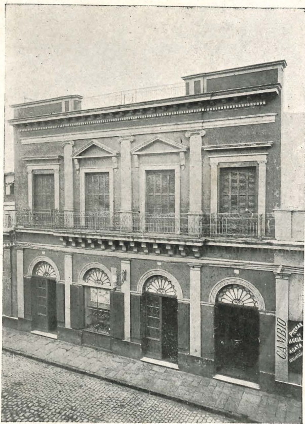
FACCIATA DELLA CASA DEL SIG. TORNATORE
