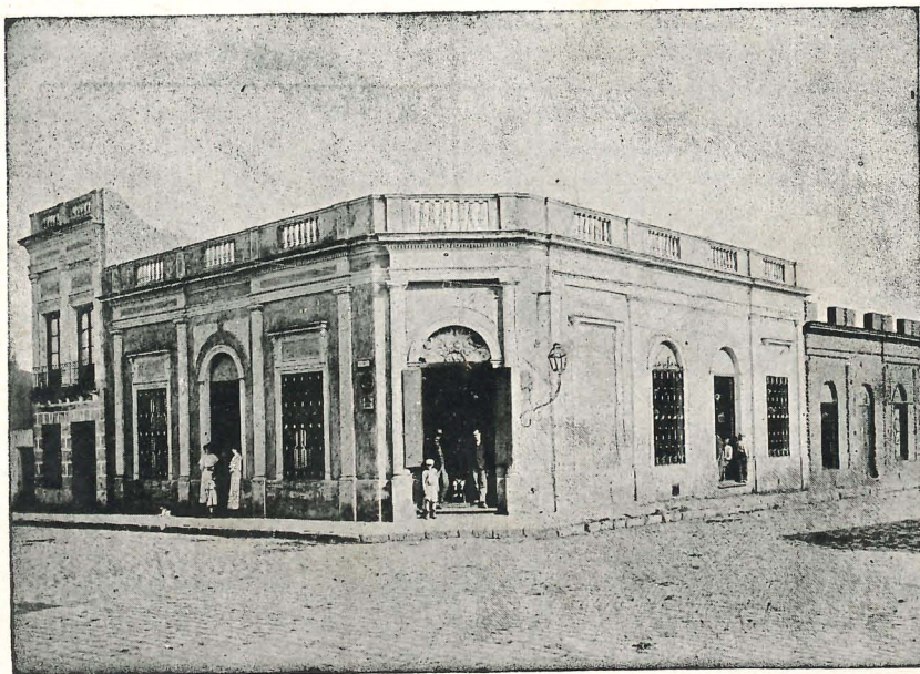
FACCIATA DELLA CASA CAMPODONICO GIOVANNI
