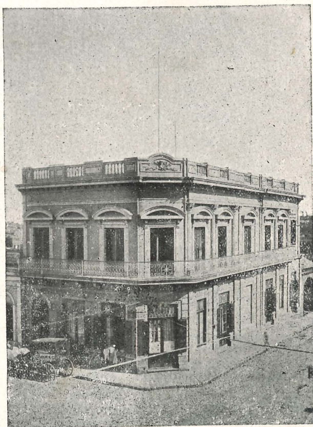
FACCIATA DELLA CASA BENEDETTO SOLARI
