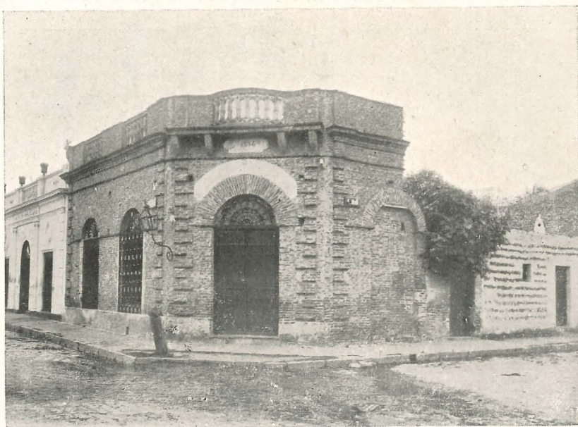
FACCIATA DELLA CASA MONTICELLI GIUSEPPE
