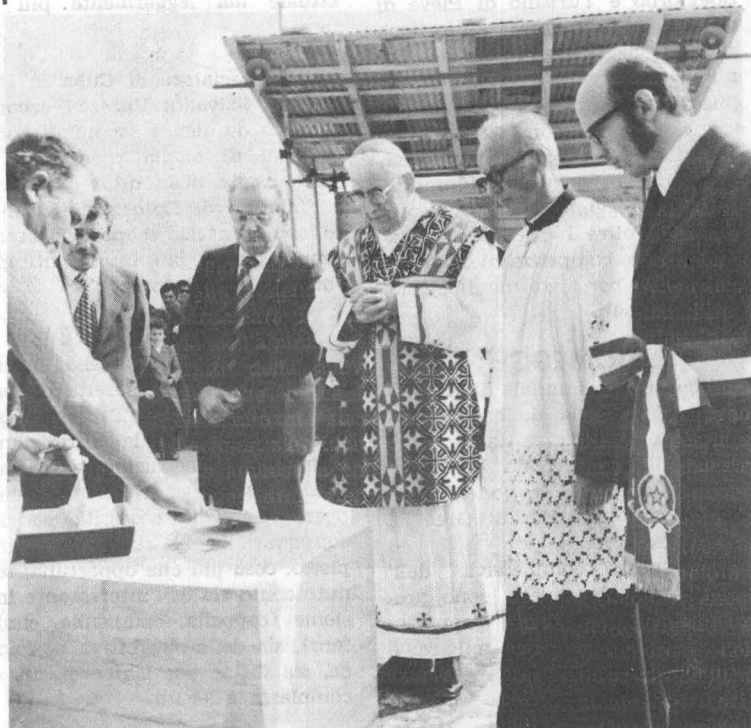
LONGARONE — Nella ricorrenza del 12mo anniversario del disastro del Vajont (9 ottobre), è stata benedetta la prima pietra della nuova chiesa parrocchiale che sarà ricostruita nello stesso posto di quella scomparsa fra le acque. Sono presenti le maggiori Autorità fra le quali il nuovo Sindaco prof. Bratti. (Foto Zanfron)
