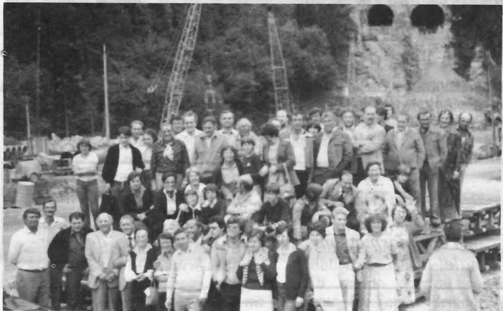
ZUG - Tutto il gruppo posa davanti ai cantieri del grande traforo autostradale.
