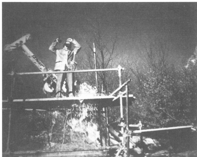
CHIES D'ALPAGO - Manca poco a Natale e l'operaio esulta: l'acqua esce con forza da un pozzo esplorativo inclinato che, penetrando per duecento metri dentro il Monte Teverone, ha intercettato una falda in pressione, orientando i tecnici verso quella che si spera sia la soluzione definitiva.
