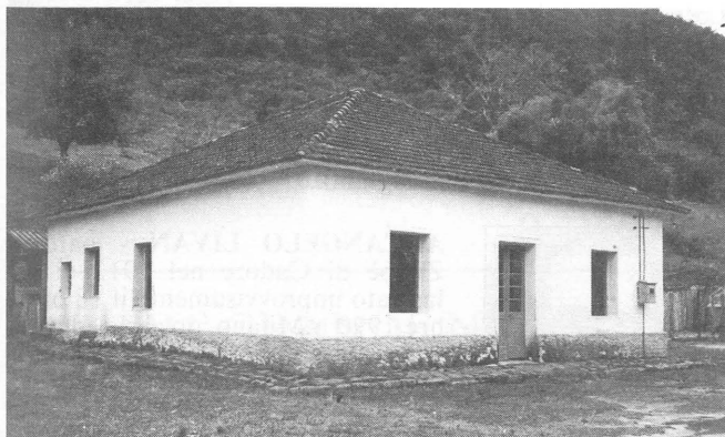
Ecco la casa della famiglia Baggio (di Belluno) costruita per il vecchio italiano Baggio che era un esimio muratore. Ora è proprietà della famiglia Piasentin.
