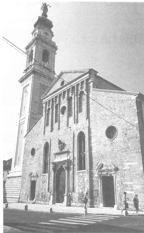
La facciata della Basilica Cattedrale di Belluno (1520-1625). (Foto Banchieri).
